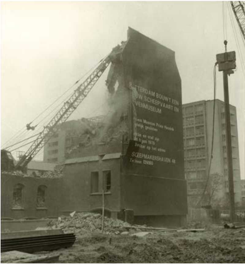
De sloop van het museumgebouw aan het 's Jacobplein, augustus 1979.
